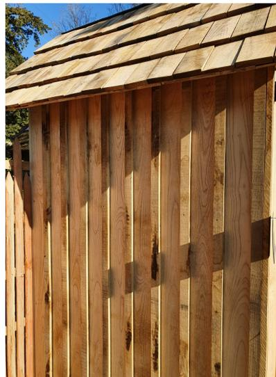
Largeur 120 et 140 mm épaisseur 20 mm avec couvre joints – longueur 2.00 m et 2.50 m
