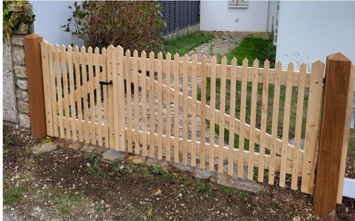
Composés de montants, traverses et écharpes en châtaignier .
